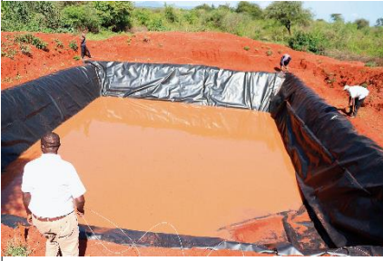
Abb. 1–3: Plastikfolie, Überdeckung mit einer Textilplane, Speichertank
