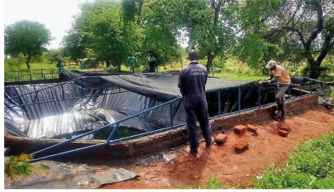
Abb. 1–3: Plastikfolie, Überdeckung mit einer Textilplane, Speichertank
