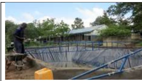
Plastikfolie und Stangengerüst
