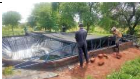
Überdeckung mit einer Textilplane
